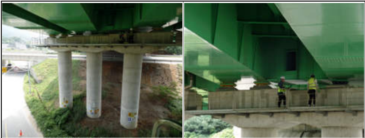
교각 점검시설 전경
