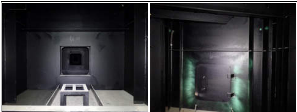
Steel Box Girder 내부 격벽 전경
