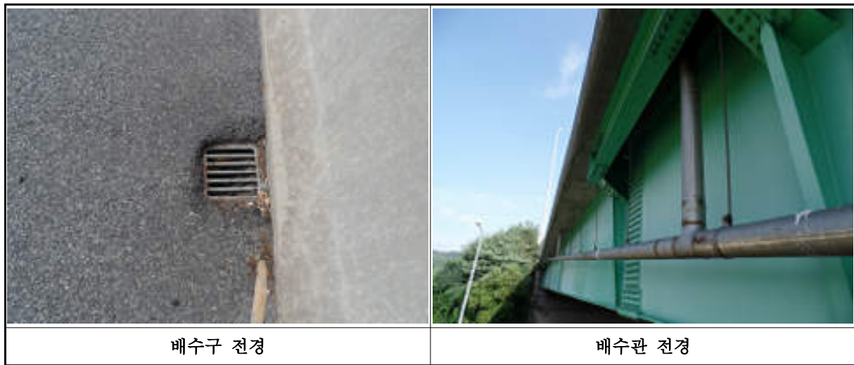
【그림 3-20】 양평방향 - 배수시설 전경
